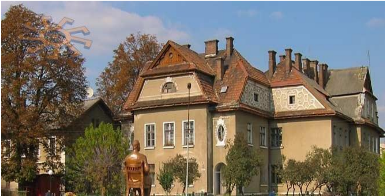
Будівля колишнього готелю Тайхманна (Teichmann)
